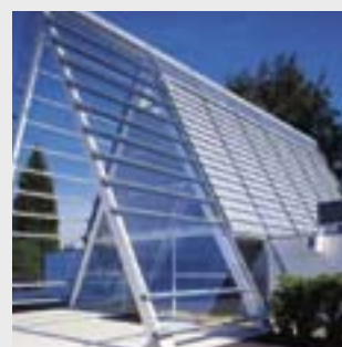
Cappella cimiteriale, Stainz Austria
