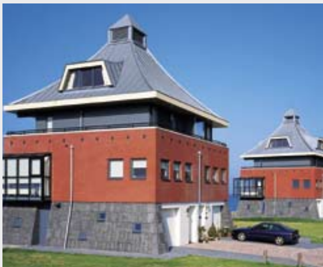
Case residenziali, Stavoren, Paesi Bassi
