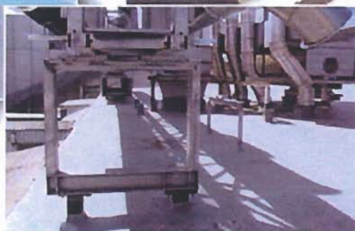
Sovrastrutture da tetto
