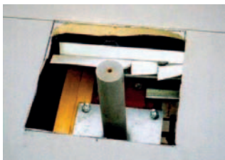
Ancoraggio tradizionale 'passante per il tetto'
