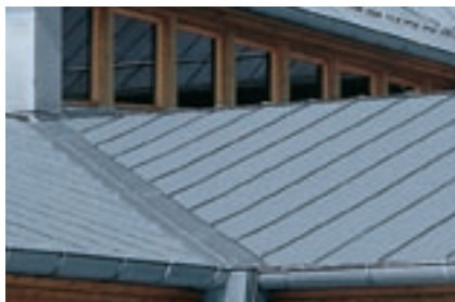
Conversa con bandella di ancoraggio stagnata
