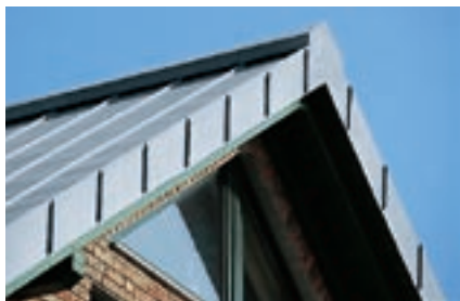
Colmo a due falde, esecuzione alta e bassa con sezioni aerate
