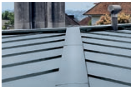
Displuvio a T con coprigiunto
