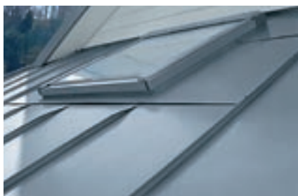
Raccordi frontali Aggraffature ripiegate con aggancio mediante bandella stagnata
