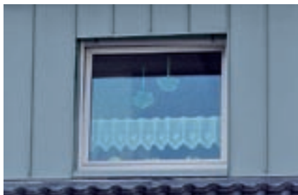
Apertura (finestra) con ripartizione simmetrica lastre
