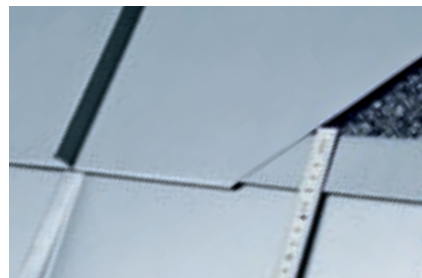
Giunzione trasversale mediante aggraffatura semplice (per larghezza limitata e sufficiente pendenza)
