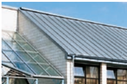
Colmo a una falda con listello in legno
