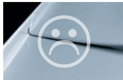
Colmo a una falda senza spazio di dilatazione e insufficiente altezza di raccordo
