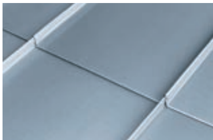
Giunzione trasversale con bandella di fissaggio stagnata
