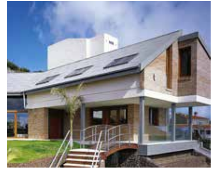
Casa residenziale Montaña del Socorro, Tafira Baja, Spagna
