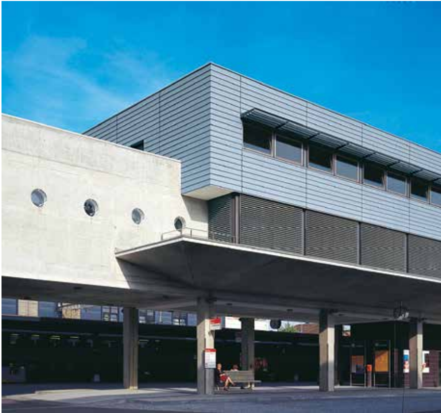
Stazione ferroviaria, Uster, Svizzera
