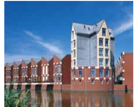
Edifici residenziali Den Bosch, Olanda
