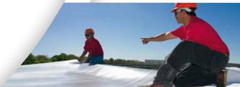
Sistemi di copertura in TPO
